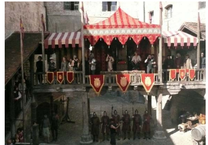
Die Königsloge für „1 1/2 Ritter“ wurde aus massivem Altholz auf der Burg errichtet – mit Steinfüßen aus verkleidetem Ytong.
